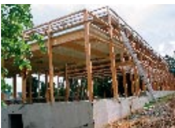
La nouvelle salle multisports prend forme
