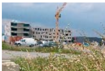
Bureaux en cours de construction de la société SPIE
